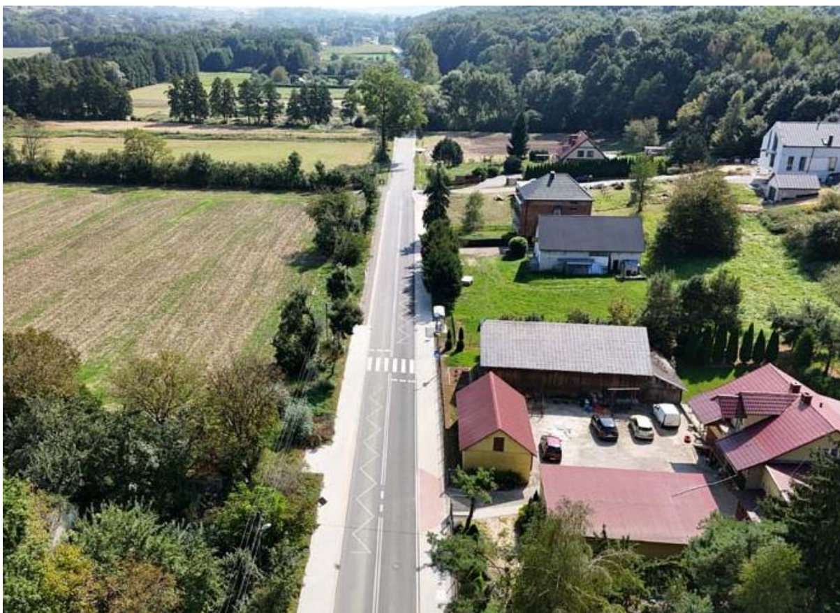
Rozbudowa drogi powiatowej nr 2155K (od km 1+538 do km 2+108) w miejscowości Młodziejowice
