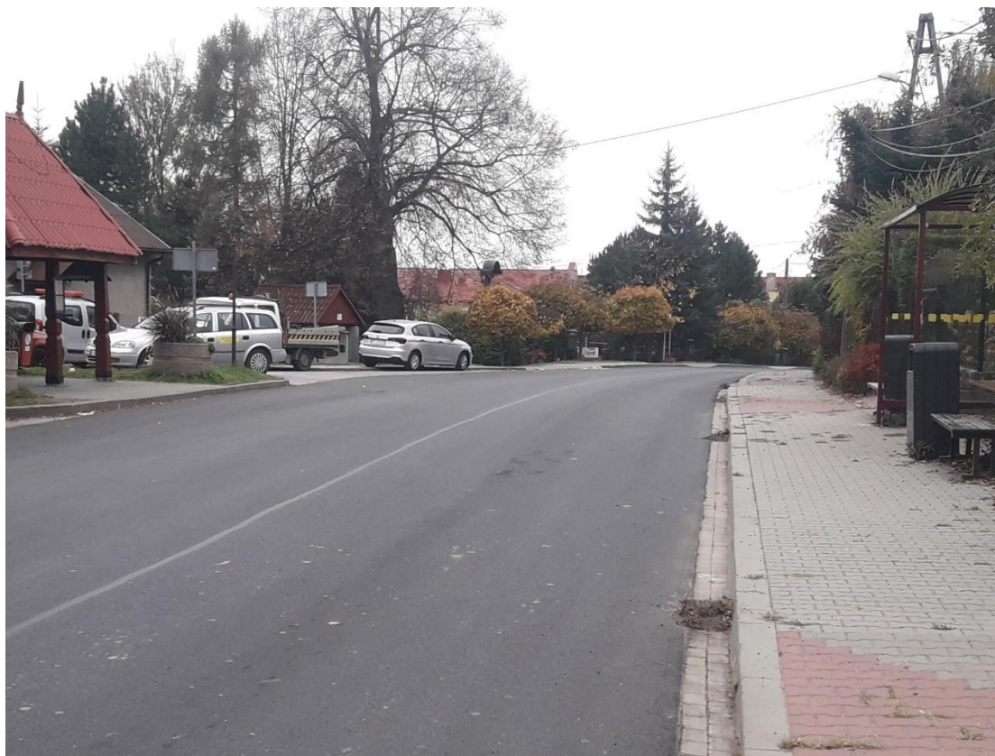
Remont nawierzchni drogi powiatowej nr 2131K w Zelkowie, gminie Zabierzów.
