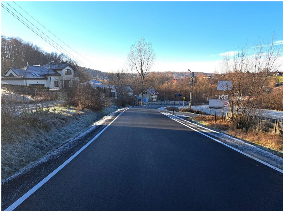
Wyremontowana nawierzchnia DP 2030K, ul. Dworskiej w Rzeszotarach, gm. Świątniki Górne
