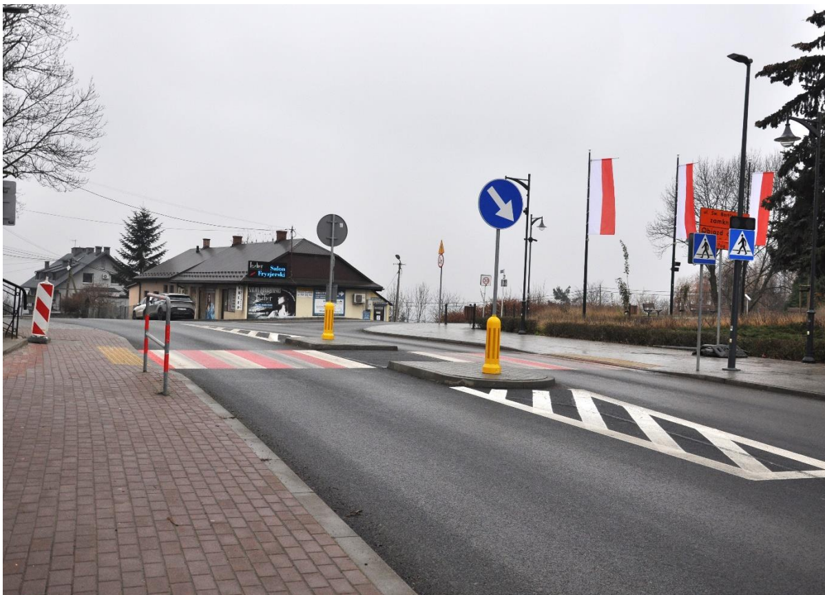
Rozbudowa DP 2173K, ul. Krakowskiej w Mogilanach
