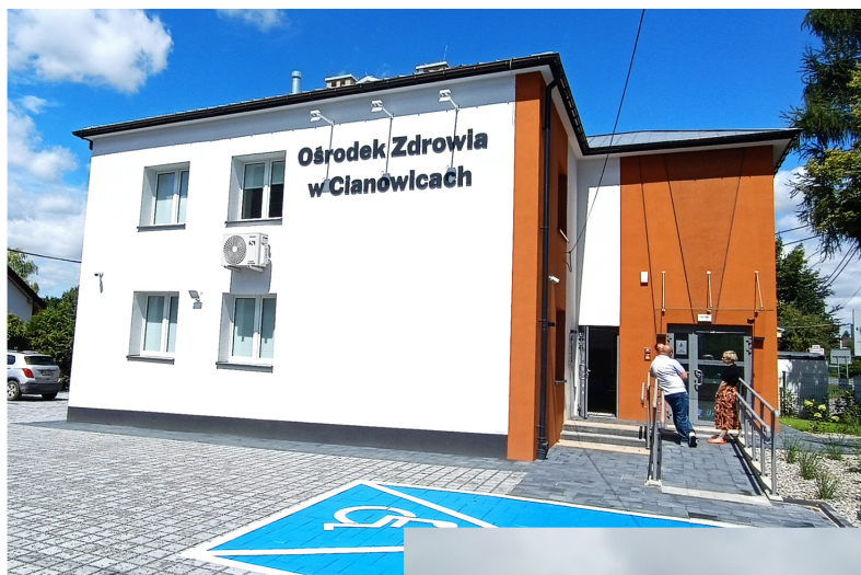
rozbudowa ośrodka zdrowia Cianowice
