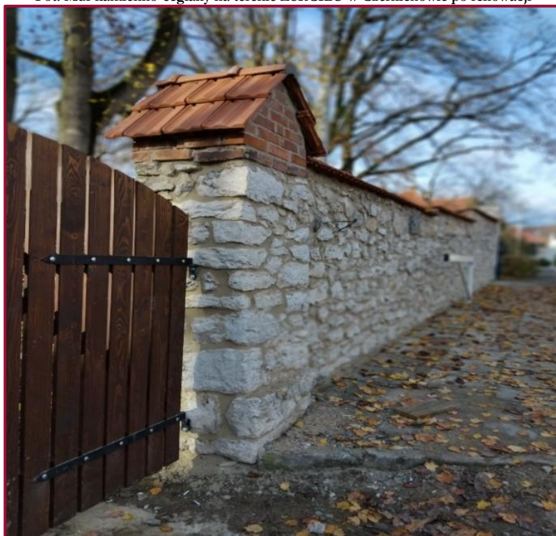
Fot. Mur kamienno-ceglany na terenie ZSRCKiU w Czernichowie po renowacji
